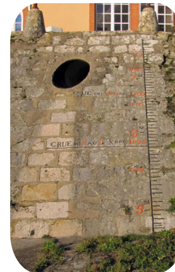
Echelle de crue Quai Penthievre
